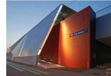
Gare de Prilly-Malley à 2km
